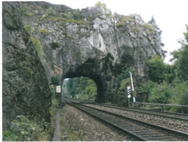
Foto: Felstor auf der Strecke Regensburg - Nürnberg in km 8,006 (Dr. Spang GmbH)
