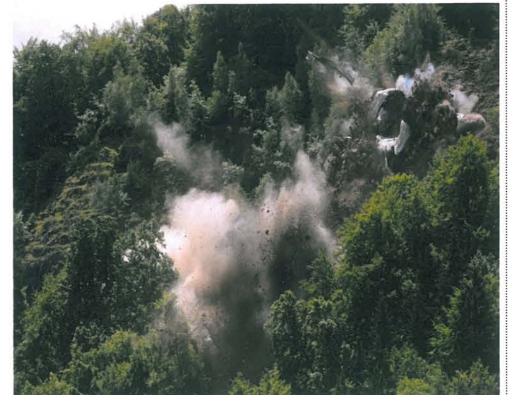
Foto: Sprengung Felstor (Dr. Spang GmbH)
