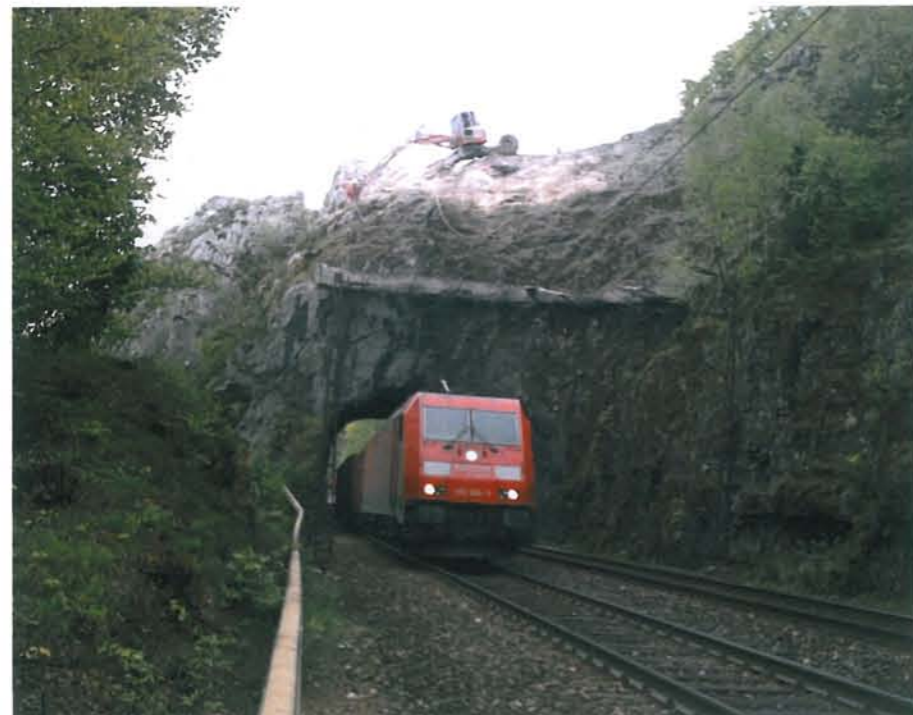
Foto: Schreitbagger auf dem Felstor (Fb Plattling Karl Bretzner)
