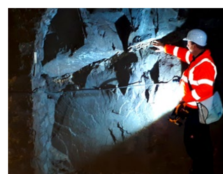
Nachroder Tunnel, Ingenieurgeologische Kartierung
