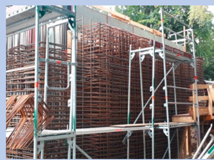
Bewehrung eines Widerlagers und einer Flügelwand der EÜ Am Stockey in Hagen
