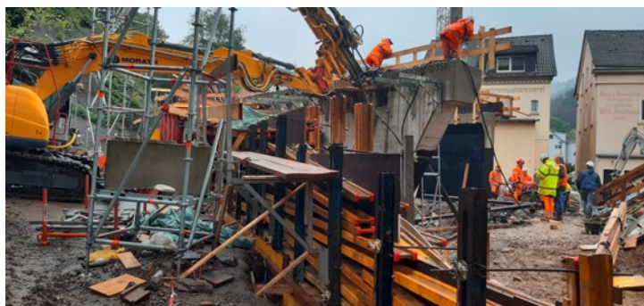
Mikropfähle zur Rückverankerung
