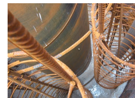
Betonage der inneren Ausbaustärkung
