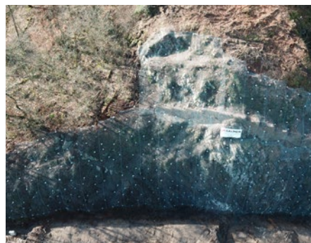
Panoramaaufnahme der Felswand aus der Drohnen-Befliegung
