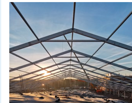
Vorbereitung der Einhausung (L x B x H = 100m x 50m x 12m)
