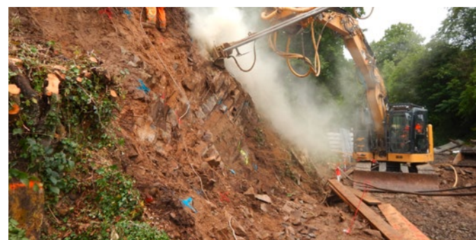
Felsnägel zur Böschungssicherung
