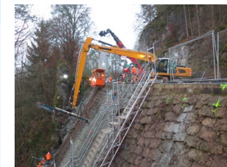
Sanierung der Steinschlichtung: Bohr- und Verpressarbeiten zur Herstellung der Spritzbetonschale.
