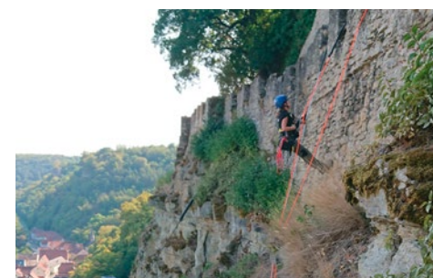
Die Geländeaufnahmen mussten fast ausschließlich vom Seil aus erfolgen
