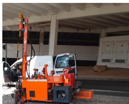
Erkundung mit dem Mini-Ramm-Zieh-Bohrgerät (MRZB) im Gebäudebestand (Tiefgarage).
