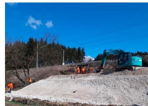
Lagenweiser Aufbau gem. Ril 836.4102A01
