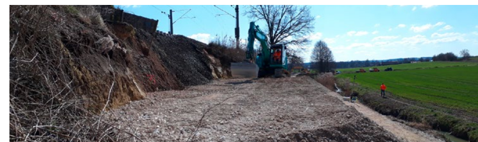
Sanierung durch Vorschüttung
