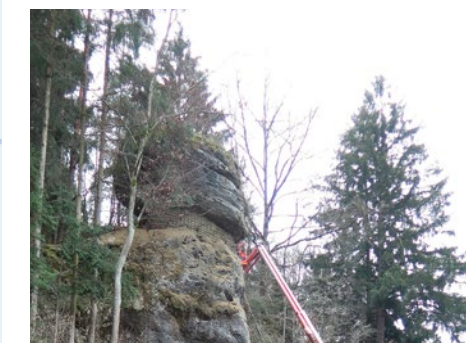
Herstellung einer rückverankerten Spritzbetonunterfangung nach vorheriger bauzeitiger Sicherung und Fundamentertüchtigung der ca. 120 m 3 Felskugel.
