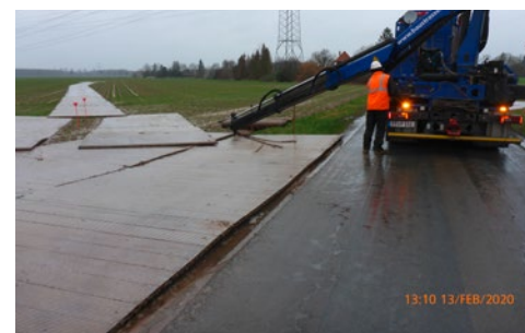
Verlegung von Aluminiumplatten für die Nutzung als mobile Baustraße
