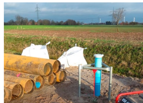
Zur Grundwasserermessstelle ausgebaute Kernbohrung
