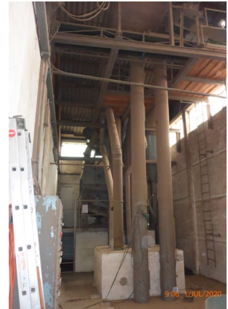
Probenahme aus der Gebäudesubstanz einer Lagerhalle
