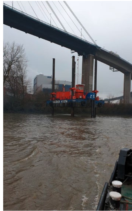
Kernbohrung von einer Hubinsel im Köhlbrand
