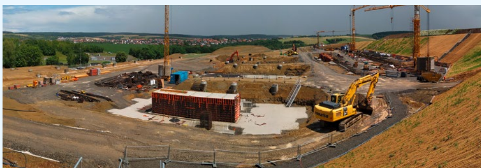
Übersichtsfoto aus der Bauphase mit drei Baugruben für die Maschinenhallen
