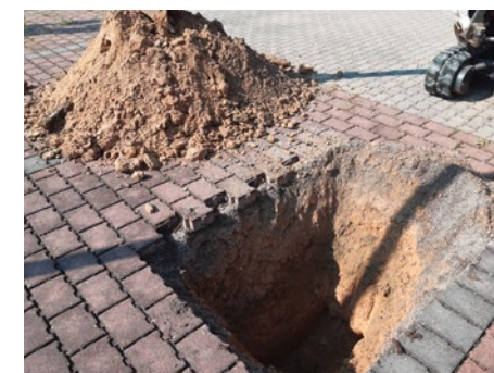
Baggerschurf zur Erkundung des baugrundaufbaus
