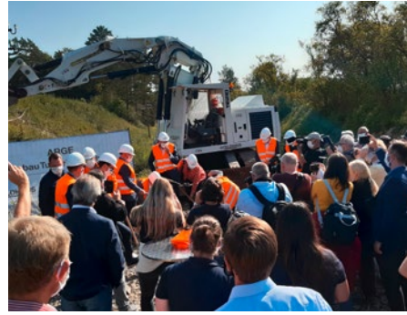
Erster Spatenstich am zukünftigen Südportal
