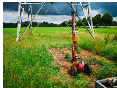
Baugrunderkundung mittels schwerer Rammsondierung neben einem Mast
