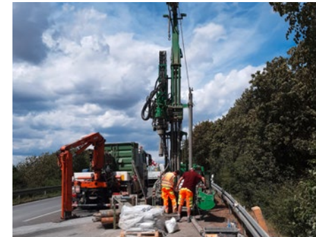
Bohrarbeiten auf dem Überführungsast AS FFN-Eckenheim
