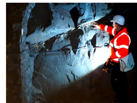
Nachrodter Tunnel, Ingenieurgeologische Kartierung einer Tunnelnische
