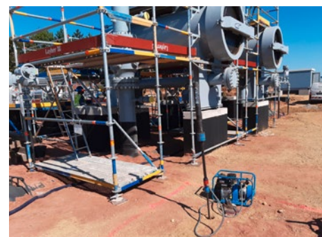
Verdichtungskontrolle einer Arbeitsraumverfüllung mittels leichter Rammsondierung
