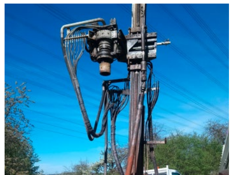
Bohrarbeiten mit Kernbohrgerät im Bereich eines Mastes
