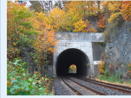
Tunnelportal des Pragpauler Tunnels
