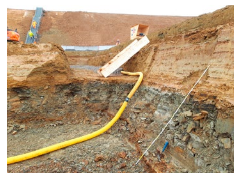
Begutachtung des Erdplanums des Versorgungsgebäudes
