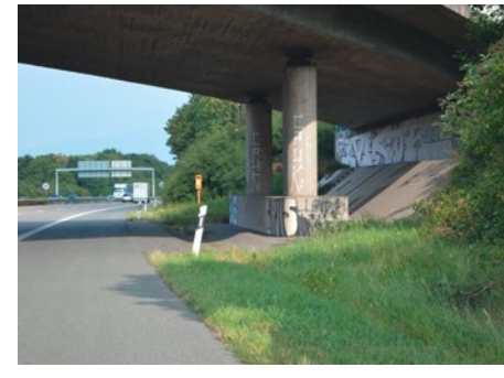
Sicht Widerlager des zu erneuernden Brückenbauwerks über die A661
