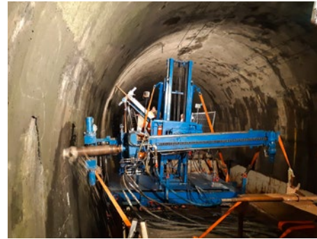
Horizontalbohrung vom Arbeitszug im Tunnel
