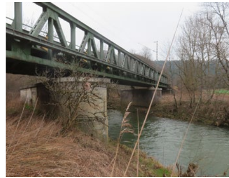
Bestehende Brücke über den Neckar
