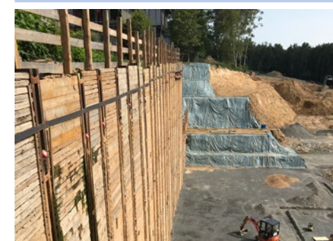
Rückverankerter Trägerbohlverbau mit Holzausfachung im Endausbauzustand
