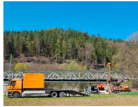
Bestehende Brücke mit Bohrgest
