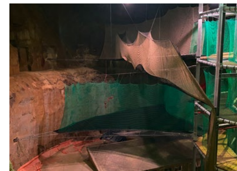
Einbau der Sprungnetze
