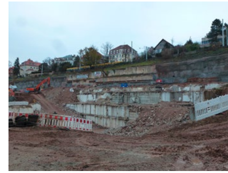
Baufeld nach Abbruch der Altbebauung
