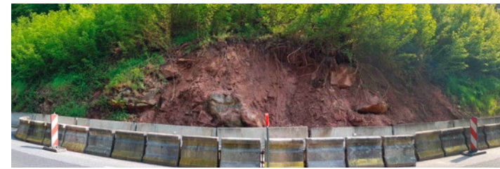
Böschung nach erneutem Blockschlag
