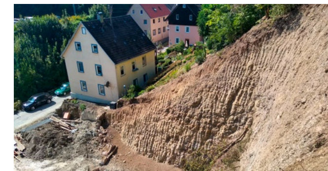
Blick in die Baugrube
