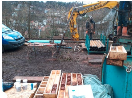
Vorbereitung Wasserdruck (WD)-Test im Bohrloch BK 35 mit Kernkisten auf der Gleisanlage der (noch) stillgelegten Hermann-Hesse-Bahn.
