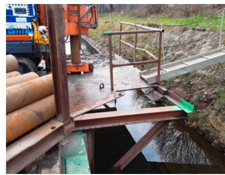
Nahaufnahme einer ulernen Kernbohrung vom Ponton
