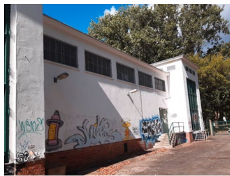
Umspannwerk Assmanstraße, seit 15 Jahren stillgelegt, direkt angrenzend an die Baustelle, Baujahr ca. 1980er Jahre, saniert 2001
