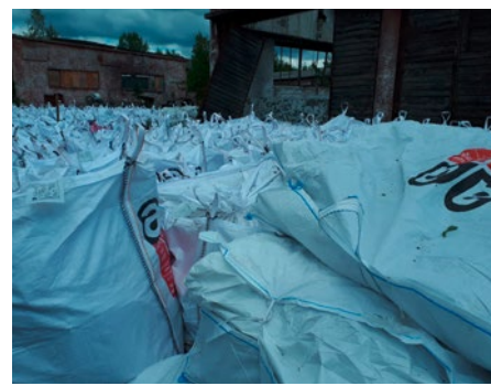
Bereitstellung Asbestabfälle zur Entsorgung
