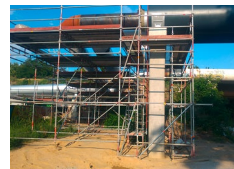
Verlegung der Fernwärmeleitung Blumberger Damm, Berlin-Marzahn
