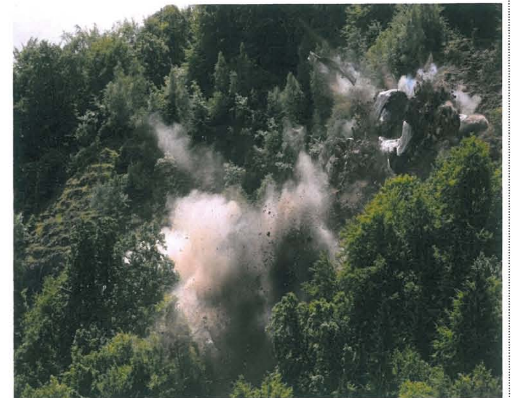
Foto: Sprengung Felstor (Dr. Spang GmbH)
