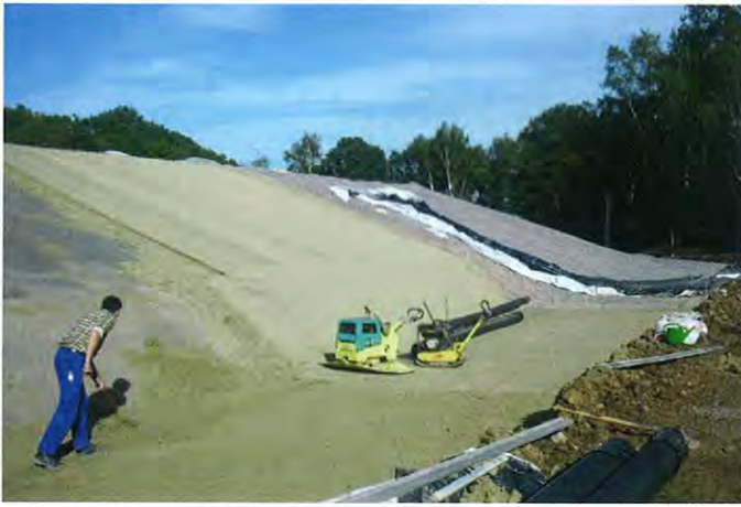
Abb. 18: Einbau der Trisoplast-Dichtung auf der Ausgleichsschicht (Mitte links) und Einbau Entwässerungsschicht (Mitte rechts)
