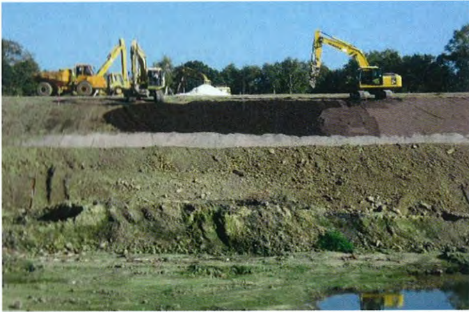
Abb. 14: Einbau Ausgleichsschicht und Gasdränage
