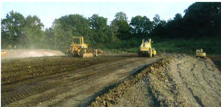
Abb. 13: Einbau Material in das Sicherungsbauwerk
