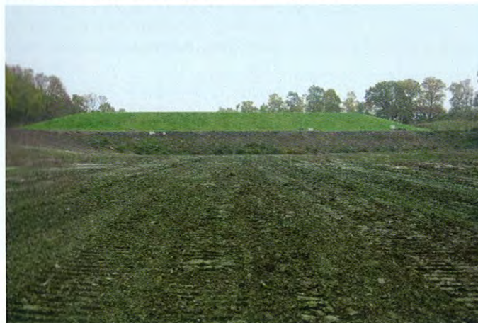
Abb. 17: Gereinigtes Aushubplanum/Sicherungsbauwerk
